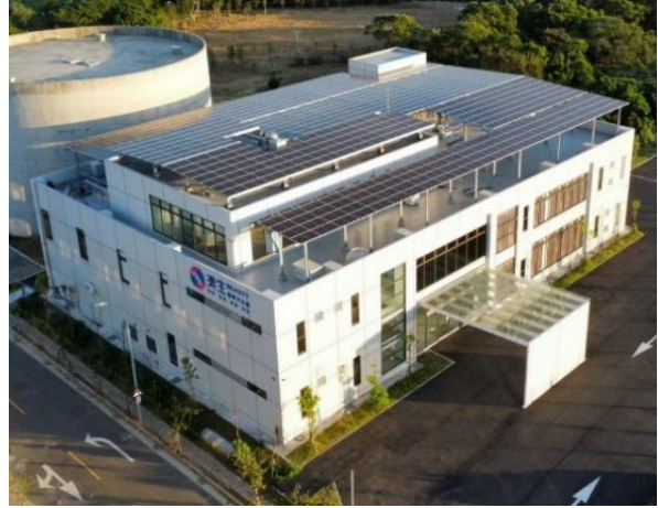
圖、觀光工廠建置太陽能發電設備
